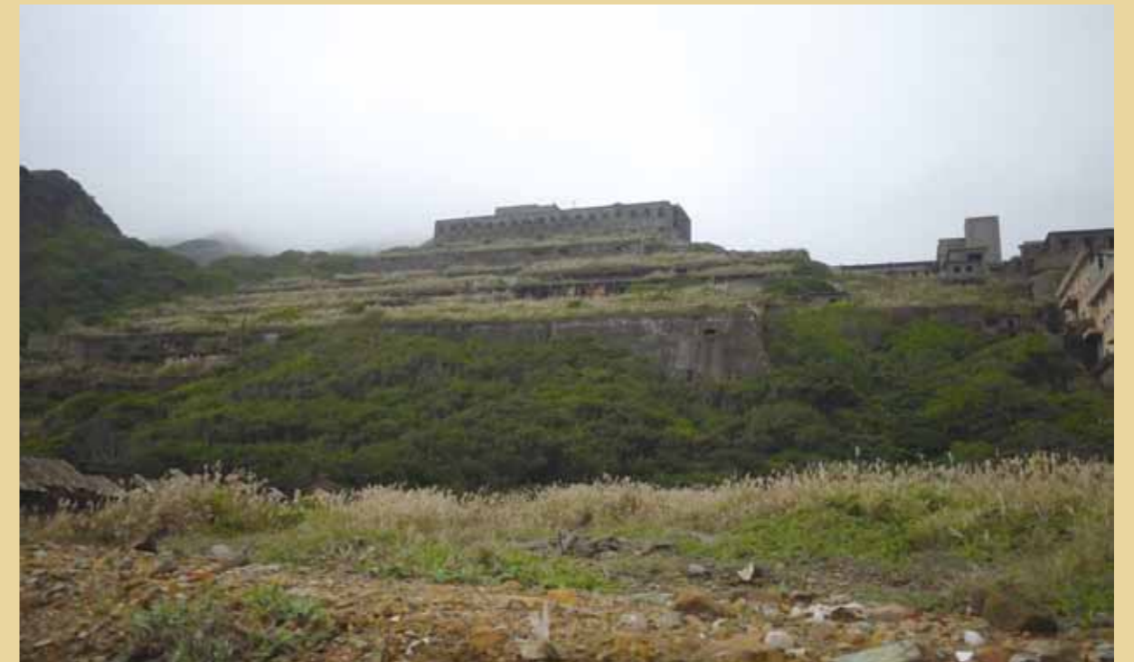
台金公司的十三層選礦廠遺址
