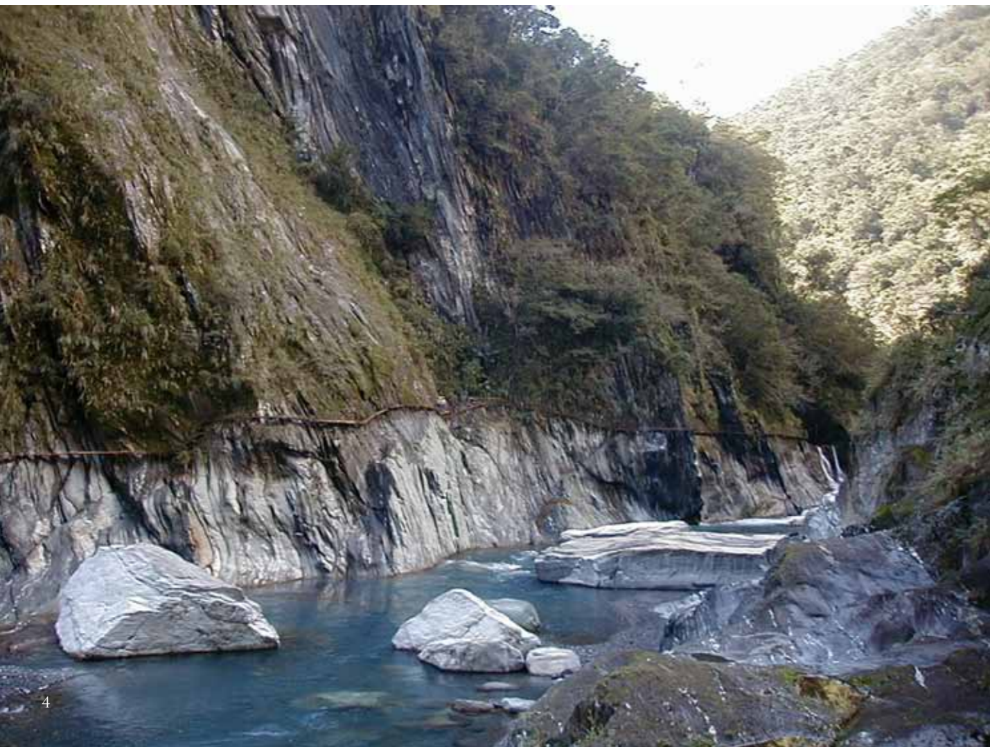
南溪壩施工棧道
