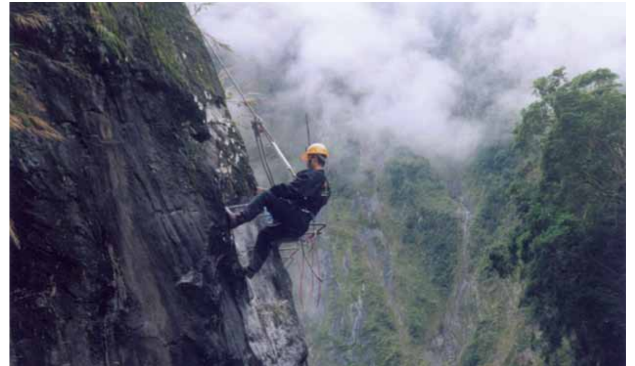
南溪壩施工棧道鋼筋孔鑽設
