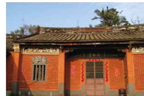
位於下大堀村的天水堂〔莊家古厝〕。
