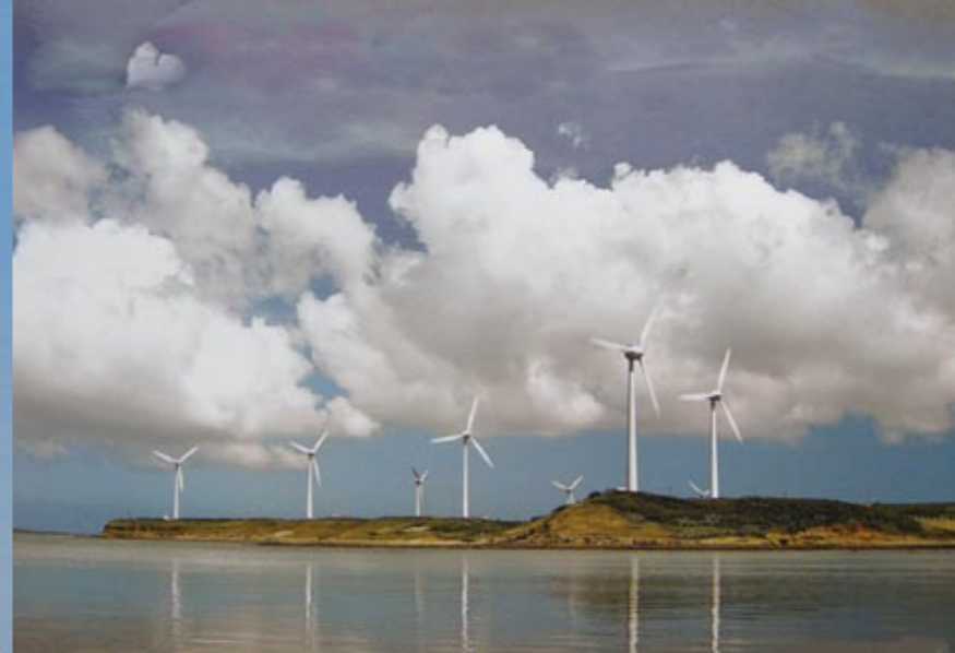
澎湖中屯風力發電站
