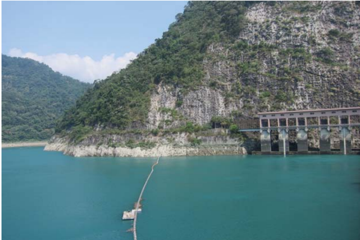
明潭下池及尾水道。
