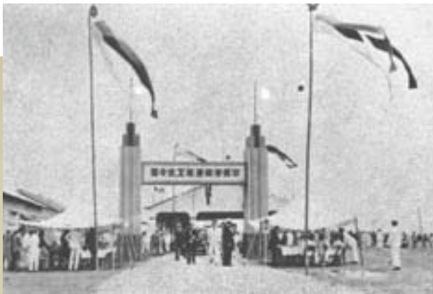
新高港建港工程現場。
