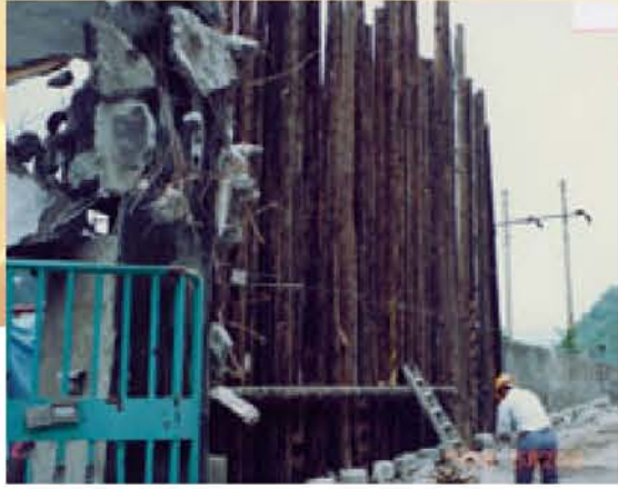
清流開關場保護設施臨時緊急搶修保護。
