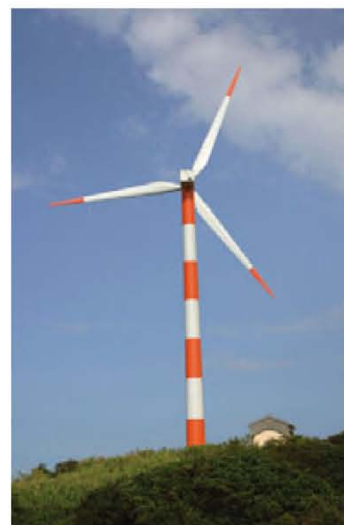
能源發展多元化，台電也開始推動風力發電，圖為金山核一廠旁的風力發電。
