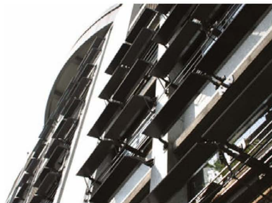
在窗戶外裝設太陽能板，不但可以發電，也可達到遮陽效果。
