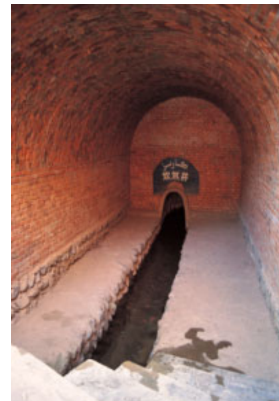
新疆取水的坎兒井，採地下化減少蒸發。
