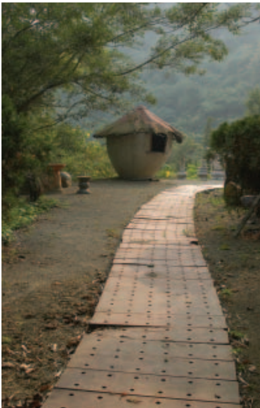
用中鋼的爐石所鋪成的步道。
