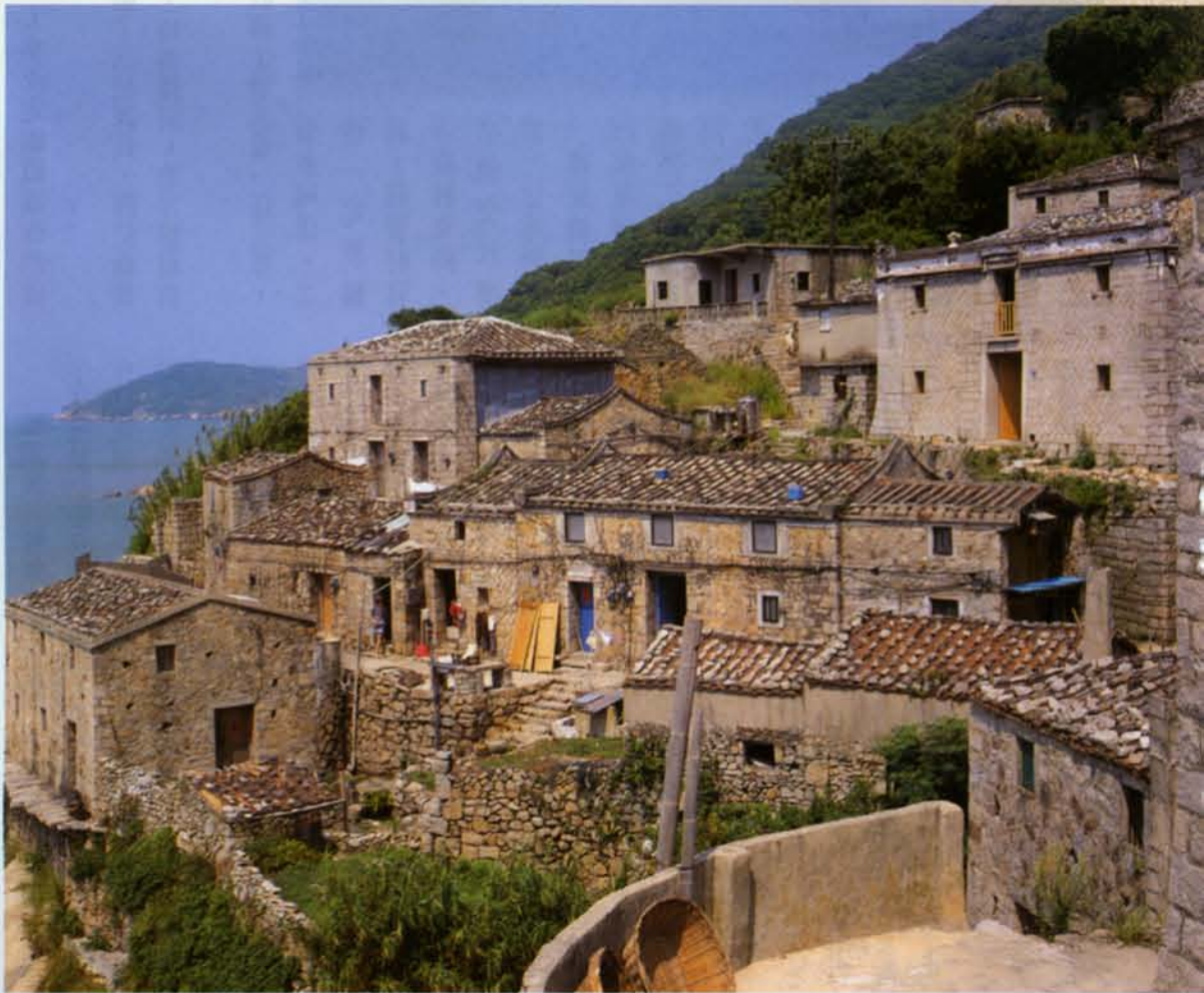
在保存地景要求電線地下化之下，台電正面臨困境。
