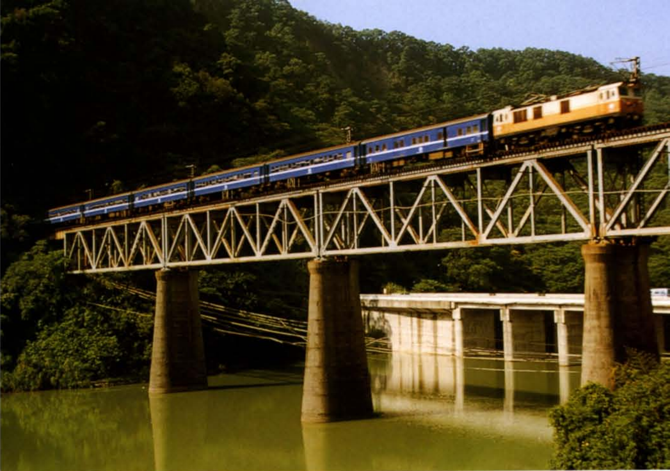
美麗的内社川橋聳立在哆囉固溪谷裡，昔日湍急的水流，變成了平靜無波的水潭。 (魏志宏/攝影)
