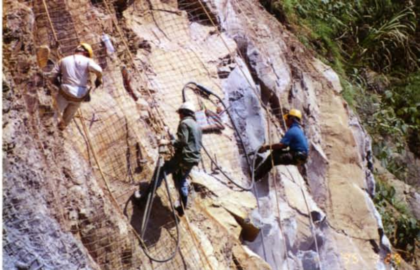
五一七的餘震，德基水庫嚴重毀損，工程人員走索道攀岩進行搶修工程。 (圖片提供/中興工程顧問公司)
