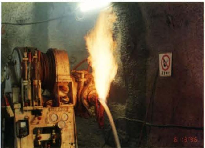
頭水隧道開挖時赫見天然氣外洩，台電工程人員冒生命危險克服困難，打通隧道。(圖片提供/中興工程顧問公司)
