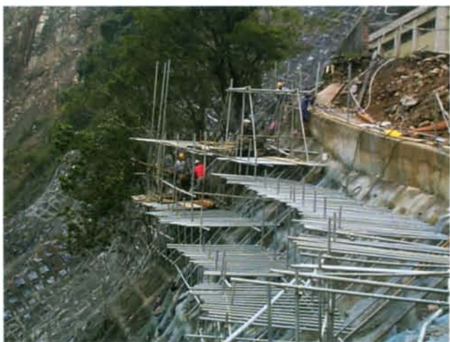
▶台電員工在危險陡峭的武界壩邊坡進行修護工程，將山壁鞏固，防止土石滑動崩塌。（明湖電廠提供）
