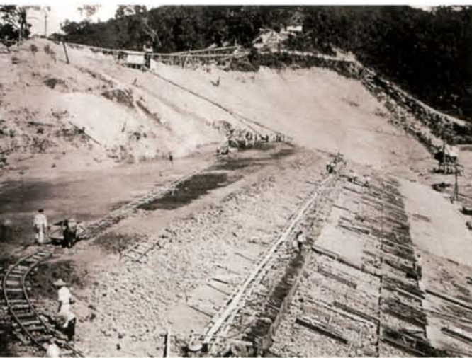
▲為提升日月潭水位，在頭社築壩堤之施工情形。
