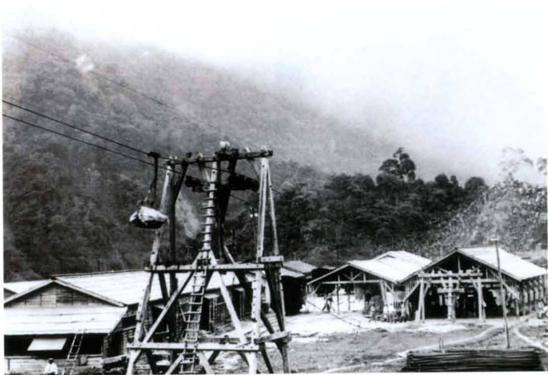
▲為便利工程施工，以索道（流籠）來搬運工事材料，圖為外車埋索道的起點。
