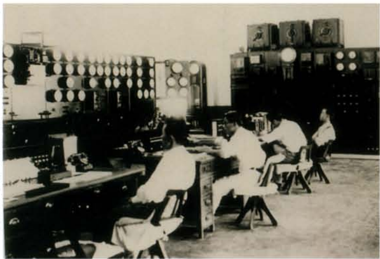
▶日月潭第一發電所（今大觀電廠）控制室配電盤。
