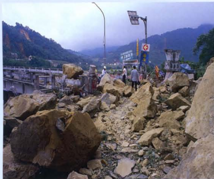
龍安橋前嚴重坍方。
