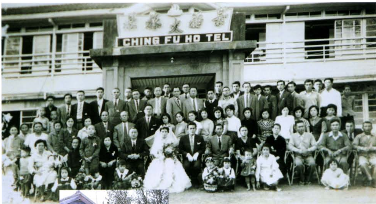
▲景福溫泉山莊在日據時代的建築照片。 (照片提供◎景福山莊)
