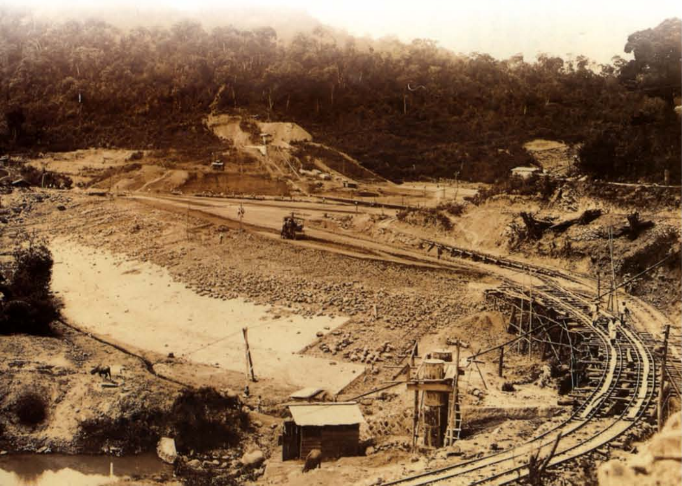
● 日據時代鉅工電廠施工用鐵路。〈鉅工電廠／提供〉
